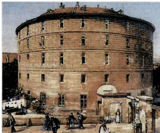
Historisch: 1784 errichtet, ist der bauliche Zustand derzeit bedenklich
